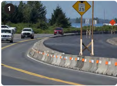
Elevación de carretera Washougal, WA
