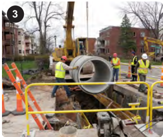
Nueva línea de drenaje entubada Hartford, CT
