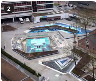
Water Square (detención) Rotterdam, NL
