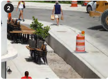
Elevación de camino tierra adentro Miami, FL
