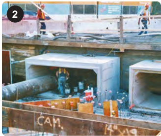
Separación de alcantarillado Cambridge, MA
