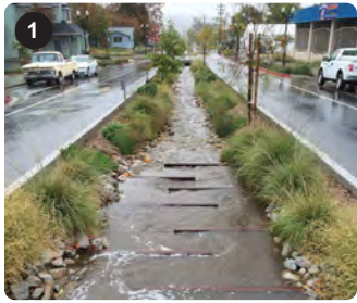
Mediana de aguas pluviales Paso Robles, CA
