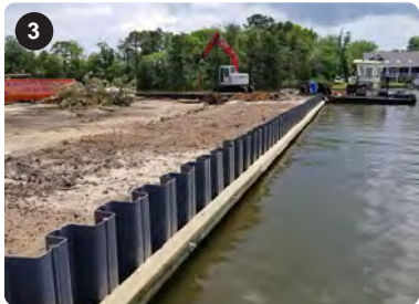
Reemplazo de mamparas + Elevación Condado de Monmouth, NJ
