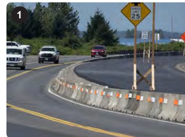
Elevación de carretera Washougal, WA
