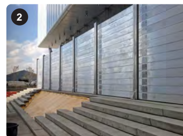
Barreras para inundaciones instalables New York, NY
