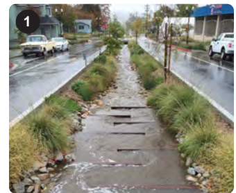
Mediana de aguas pluviales Paso Robles, CA
