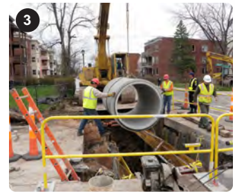
Nueva línea de drenaje entubada Hartford, CT
