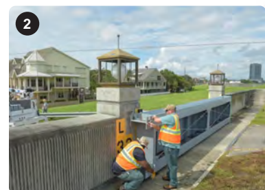
Compuertas para inundaciones Metairie/New Orleans, LA
