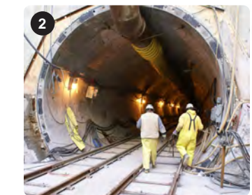
Túnel de almacenamiento y transporte South Boston, MA
