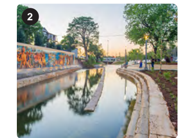
Restauración del arroyo San Pedro San Antonio, TX
