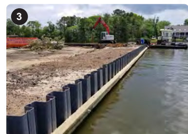
Reemplazo de mamparas + Elevación Condado de Monmouth, NJ
