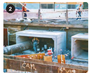
Separación de alcantarillado Cambridge, MA
