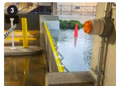
Compuerta para inundaciones automática Houston, TX
